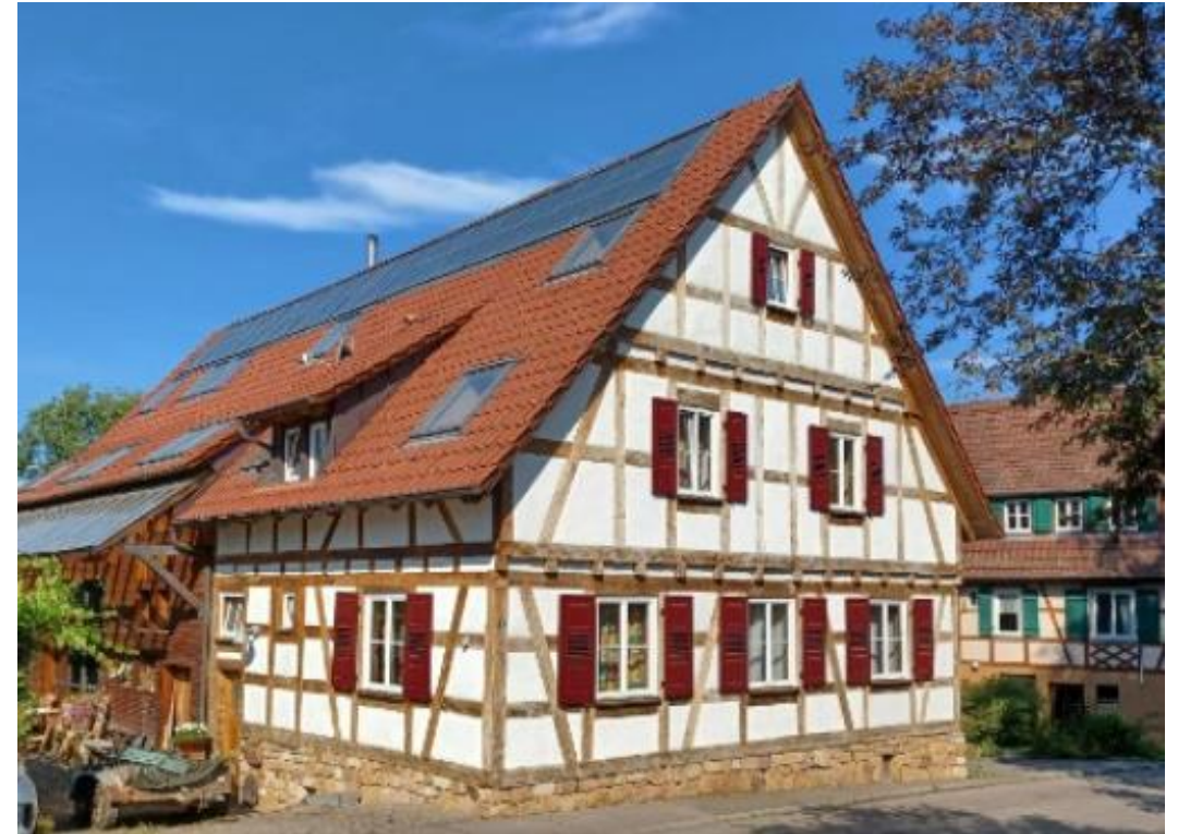
Beispielfoto einer erfolgreich abgeschlossenen Modernisierung
