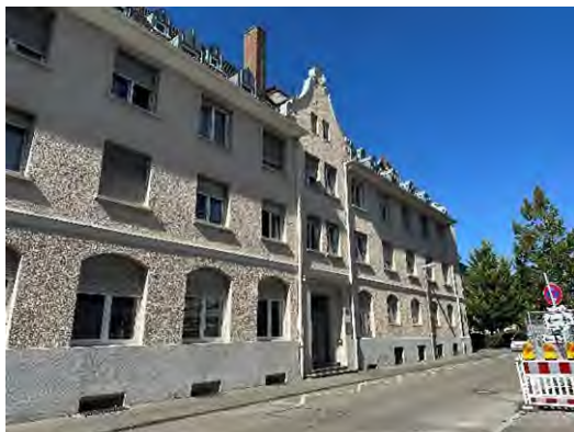
Abbildung 17: Modernisierungsbedürftiges Haus der Vereine (Quelle: WHS, 2025)
