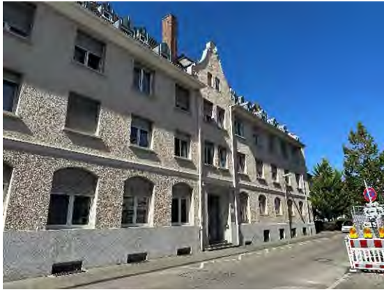
Abbildung 35: Haus der Vereine in der Steinachstraße (Quelle: WHS, 2025)
