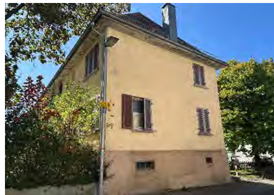
Abbildung 30: Haus in der Steinachstraße (Quelle: WHS, 2025)
